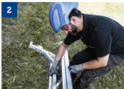
2 Geländerpfosten auf den Leitern befestigen.
