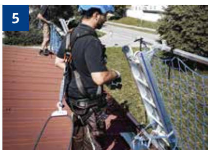
5 Geländer (und Netz) befestigen.
