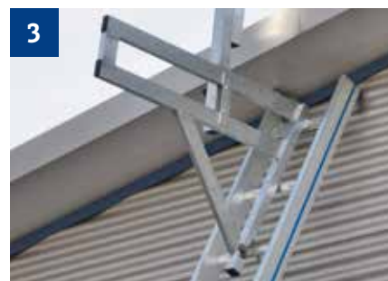
3 Leitern aufrichten und bis unter den Dachüberstand ausfahren.
