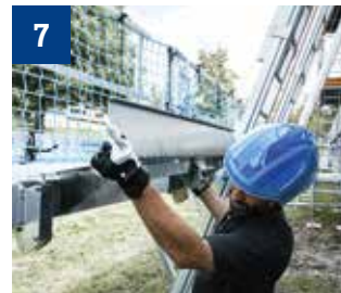
7 Bei Bedarf Überbrückungsblech mit Bordbrett montieren.
