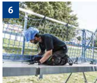
6 Schutznetz befestigen.
