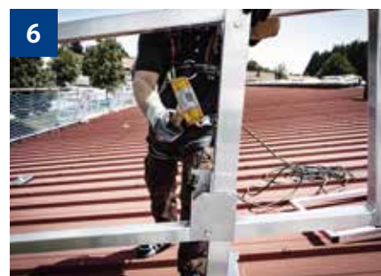
6 Geländer mittels Keilsicherung fixieren.
