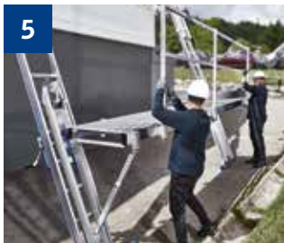
5 Gelände in Arbeitsbühne einstecken und bei Bedarf Personen-Fangnetz oder Rückseitengeländer anbringen.
