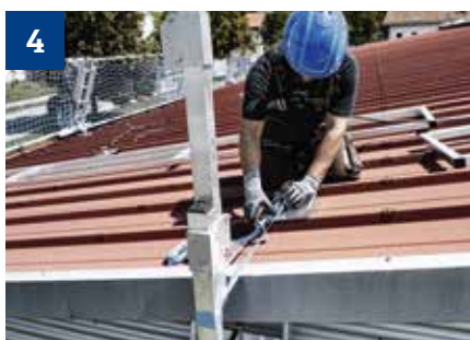
4 Pfosten mit Zurrurt verankern.
