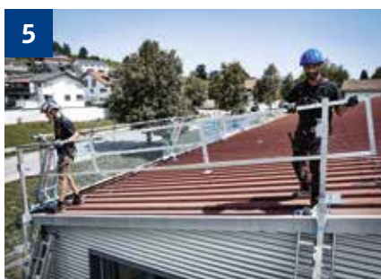
5 Geländer in Pfosten einhängen.
