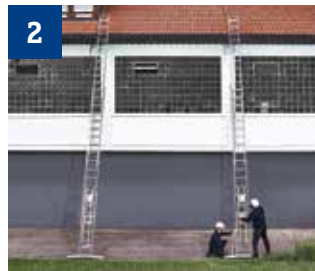
2 Verstärkte BAVARIA Leitern als Stützleitern aufstellen.
