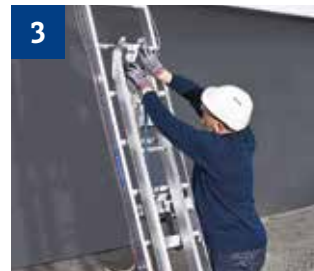
3 Schlitten an der Leiter einhängen und das Seil befestigen.
