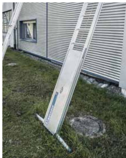
Zugangssperre nach Arbeitsende montieren (Siehe Seite 13).
